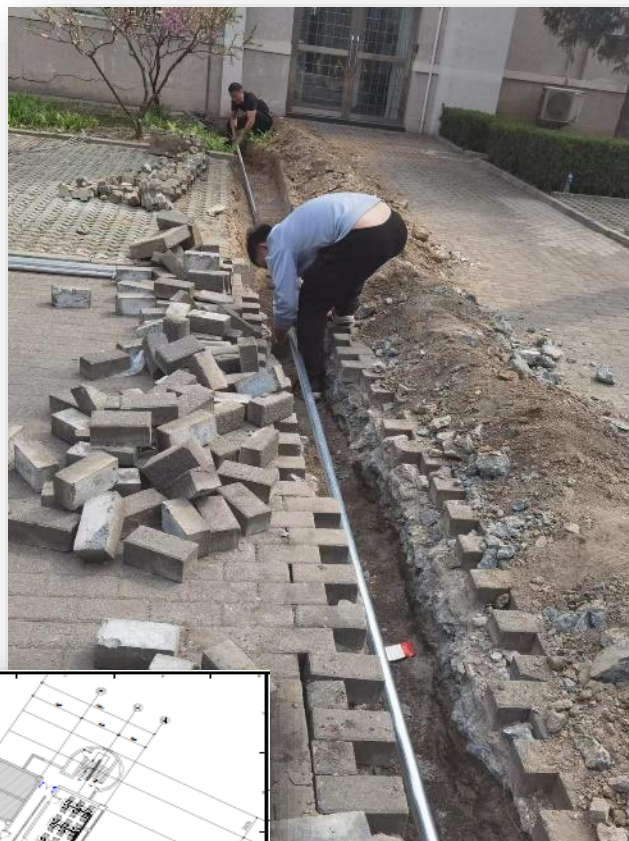
▽校史馆旧址光缆敷设▽
