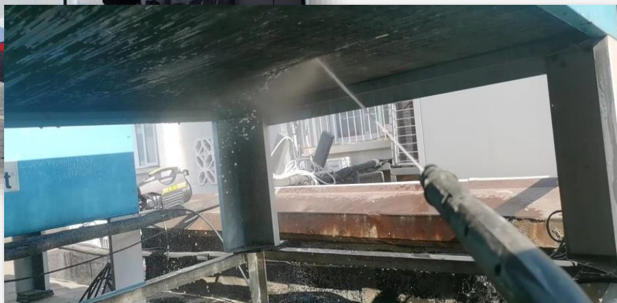
冲洗空调外机 ▶
